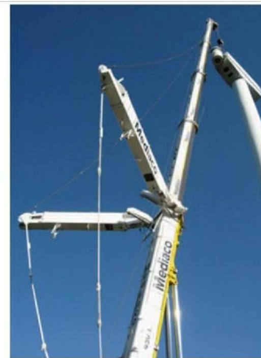
3 - Evacuation des composants de la nacelle (générateur, moyeu)
