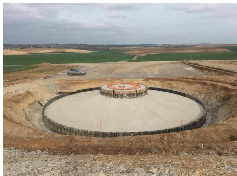
Figure 221 : Exemple d'une fondation (source : EDF Renewables, 2017)
