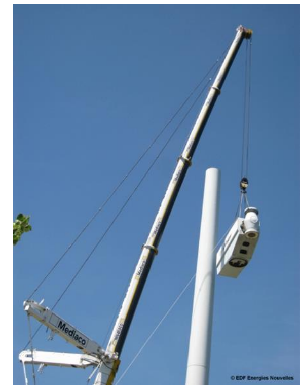
Figure 231 : Illustration du démontage d'une nacelle d'éolienne à l'aide d'une grue (source : EDF Renewables, 2017)
