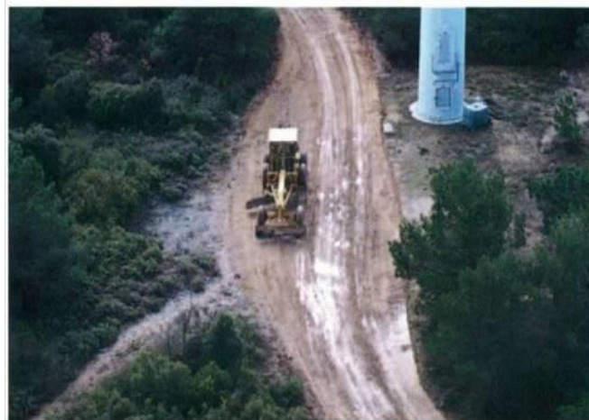
1 - Début des travaux et préparation des accès
