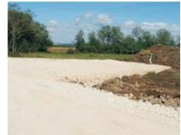
Etat final d'une plateforme
