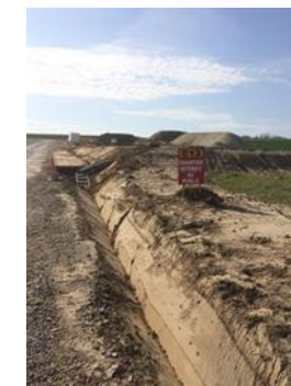
Tranchée pour la pose de câbles
