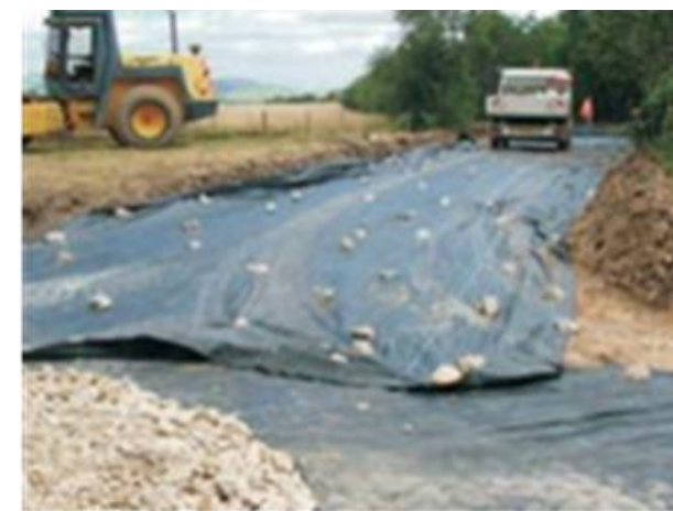
Pose d'un géotextile
