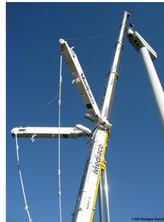
Figure 231 : Illustration du démontage d'une nacelle d'éolienne à l'aide d'une grue (source : EDF Renewables, 2017)
