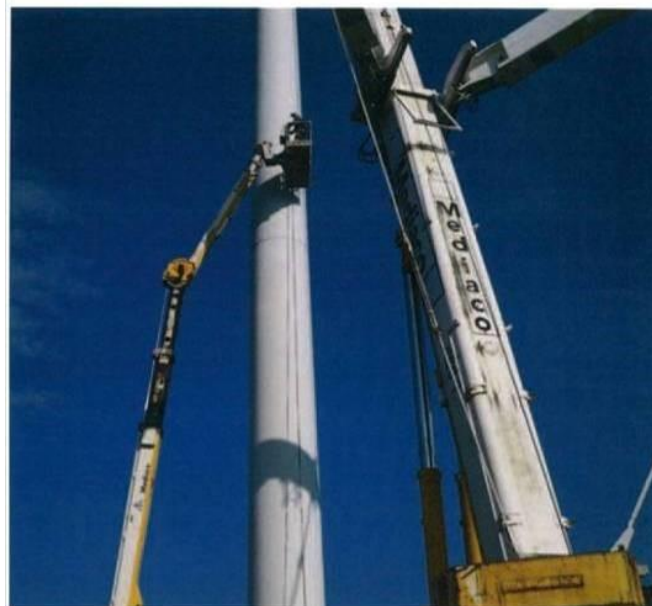
5 - Découpe pour dépose du premier tronçon du mât
