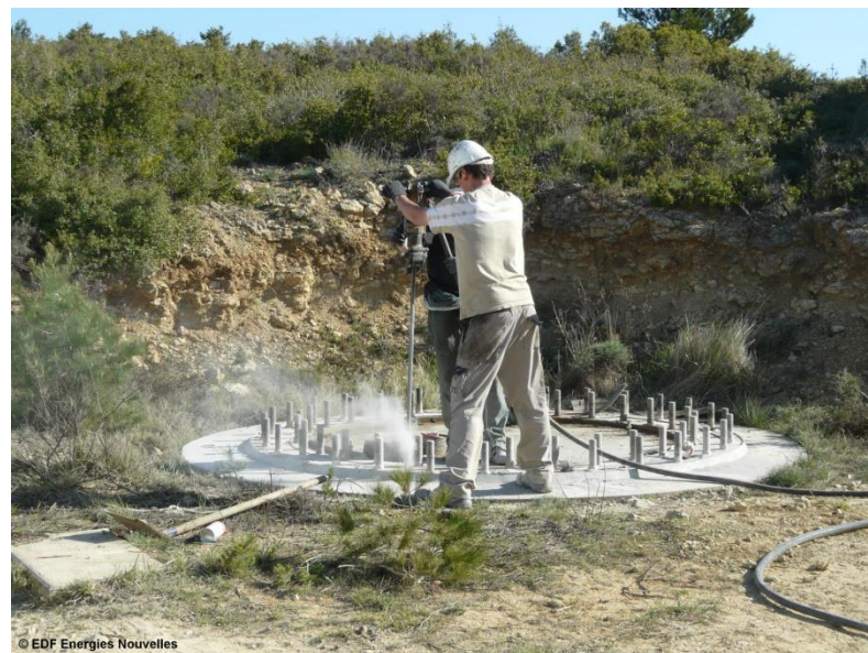
Figure 233 : Excavation d'une fouille d'éolienne (source : EDF Renouvelables, 2017)
