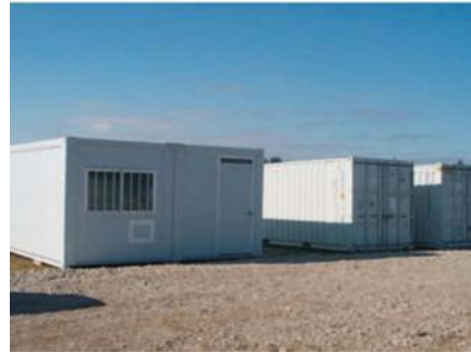
Figure 227 : Installation de la base vie (source : EDF Renewelables, 2017)
