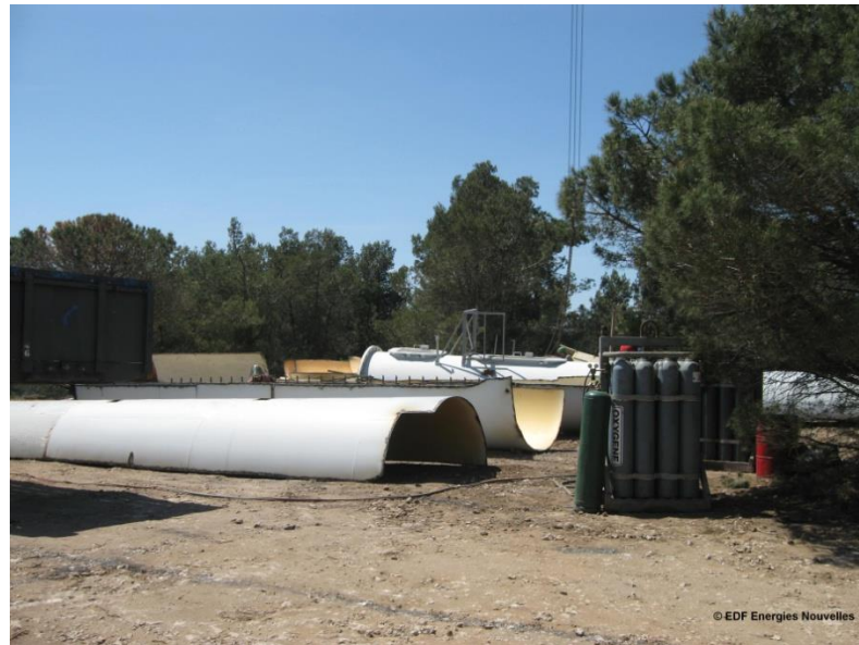
Figure 232 : Depose d'une tour d'éolienne (source : EDF Renouvelables, 2017)
